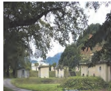
B 八町浄水場
