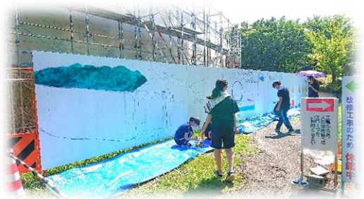
須坂版画美術館長寿命化改修工事
