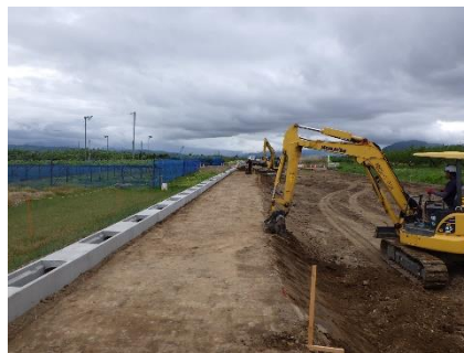
須坂長野東インターチェンジ周辺の道路整備
