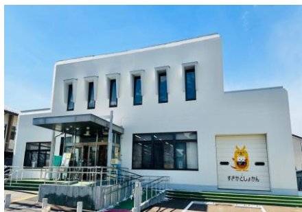
市立須坂図書館長寿命化整備
