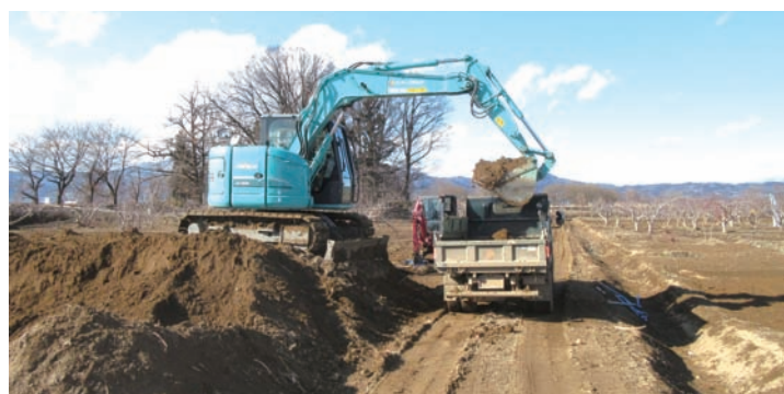
排土作業の様子
