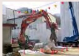
解体中の清掃センター
