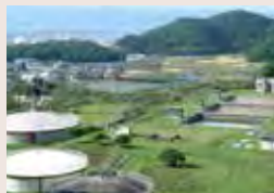
浄水場(写真は坂田)
