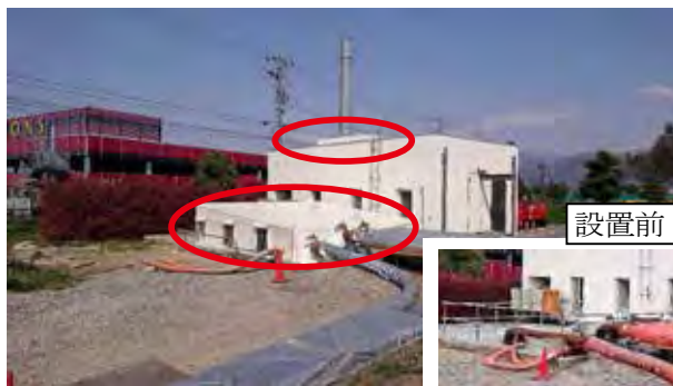
写真3: 下水流入開口部の覆い設置(4/30～)
