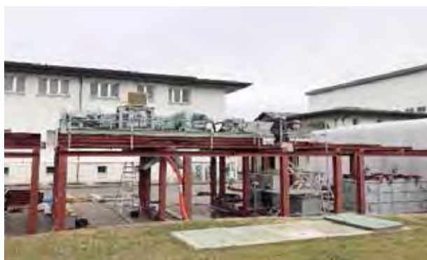
写真2: 仮設汚泥脱水機(2/19～)
