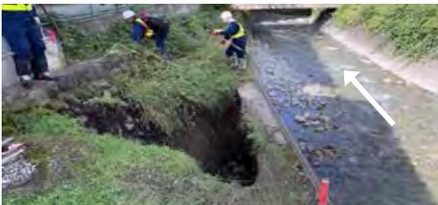
▲奈良川寺村橋上河床低下による護岸の被災
