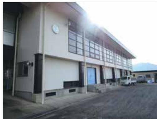
日野地域公民館の多目的ホール
