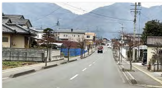
八町線 小山区間の道路「！」
