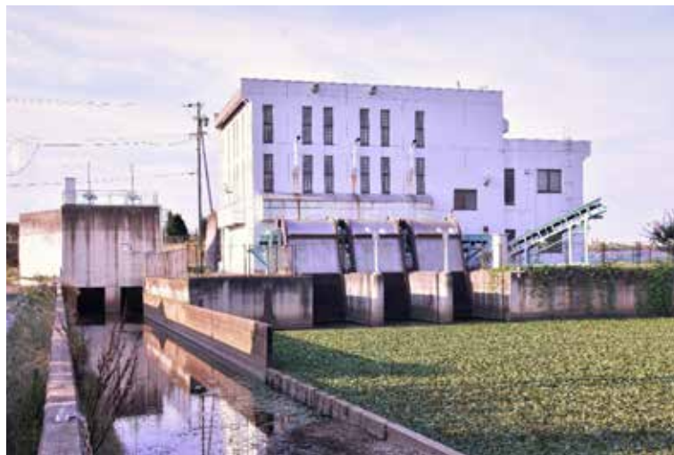
排水能力アップが求められる福島排水機場
