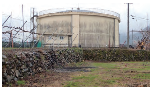
待望のエアレーション施設が新設される予定の野辺原配水場隣地
