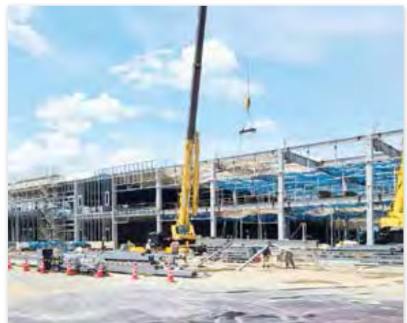
インター周辺、ものづくり産業施設内の建設途上の工場建屋
