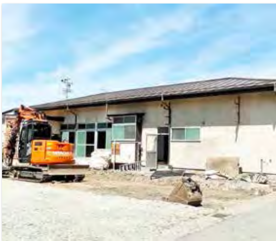
北横町公会堂改修の現場
