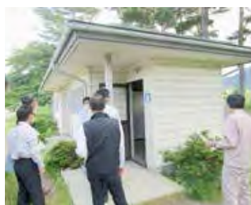
県民須坂運動広場南側の外トイレ改修予定箇所を現地調査
