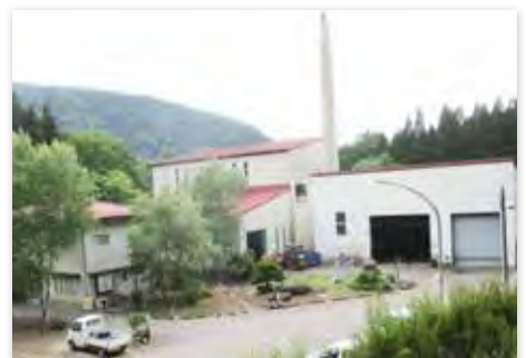
解体予定の清掃センター
