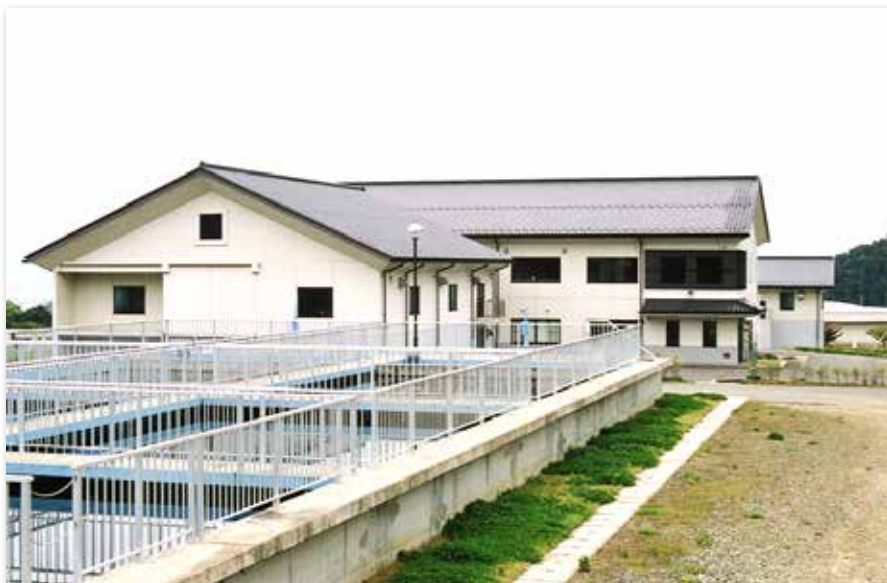
平成8年しゅん工の塩野浄水場
