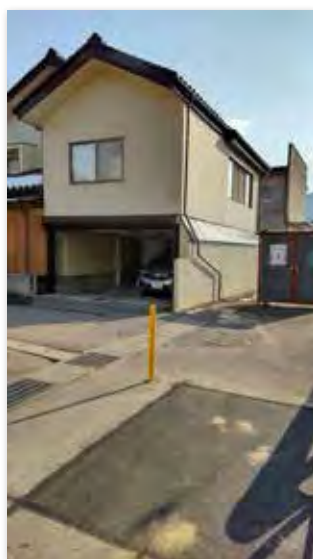
真ん中に杭がある市道
