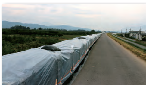
高さ約80cmの大型の土のうを設置(10月4日)
