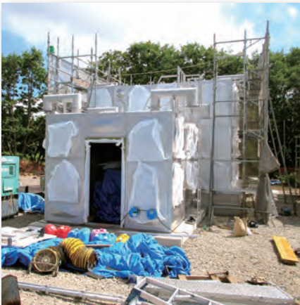
高区配水池築造工事現場
