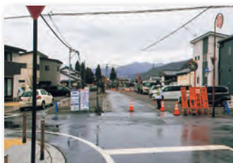
工事を開始した泉小路(劇場通り～国道406号)
