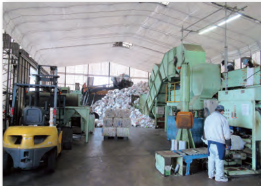
老朽化が著しいストックヤード
