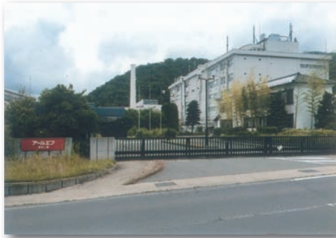
扉の開かないアールエフ須坂工場
