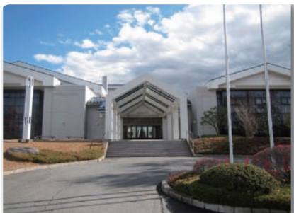
改修予定のメセナホール
