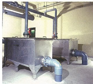
■汚水計量槽 流量調整ポンプで移送された汚水は微細目スクリーンをへて汚水計量槽で2系列に分けられます。
