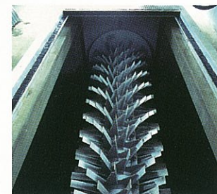
■オキシデーションディッチ槽 横型のばっ気・攪拌方式のロータの採用により、酸素供給量が多く、少ないエネルギーで効率的な攪拌が可能です。また無終端水路型のばっ気槽のため嫌気・好気の状態を保つことが容易で脱窒素に効果的です。
