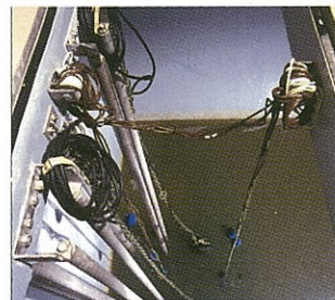
■原水ポンプ槽 自動粗目スクリーン等で前処理された汚水を流量調整槽に移送するためのポンプ槽です。
