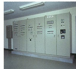
■自動運転操作盤 処理装置を自動的に自動運転制御し、各装置の作動状況を確認します。
