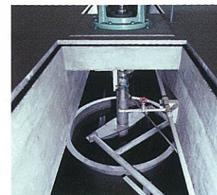
■沈殿槽 ろ床槽ばっ気槽で生成された生物性汚泥を沈殿分離させます。
