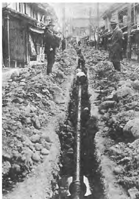
大正14年4月 中町通りで鉄管敷設工事
