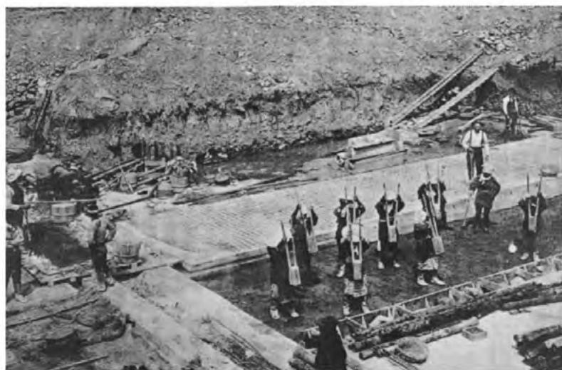
大正14年5月 坂田配水池敷底鉄筋混凝土工事
