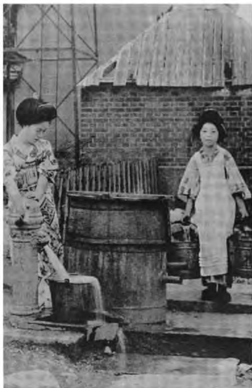
創設当時の共用栓と創設前の簡易水道の水槽
