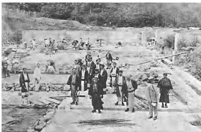
大正14年8月 ろ過池敷コンクリート工事を実況視察する町会議員
