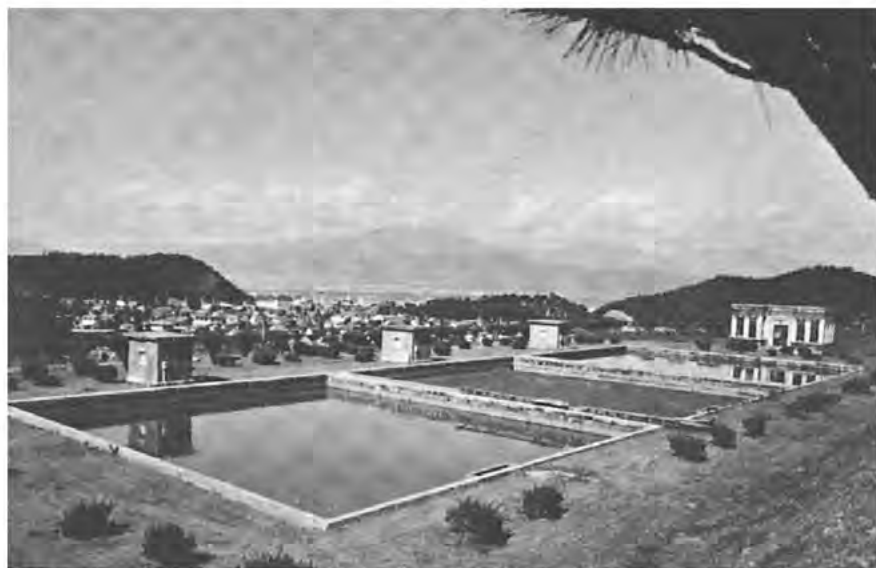
現在の坂田浄水場
