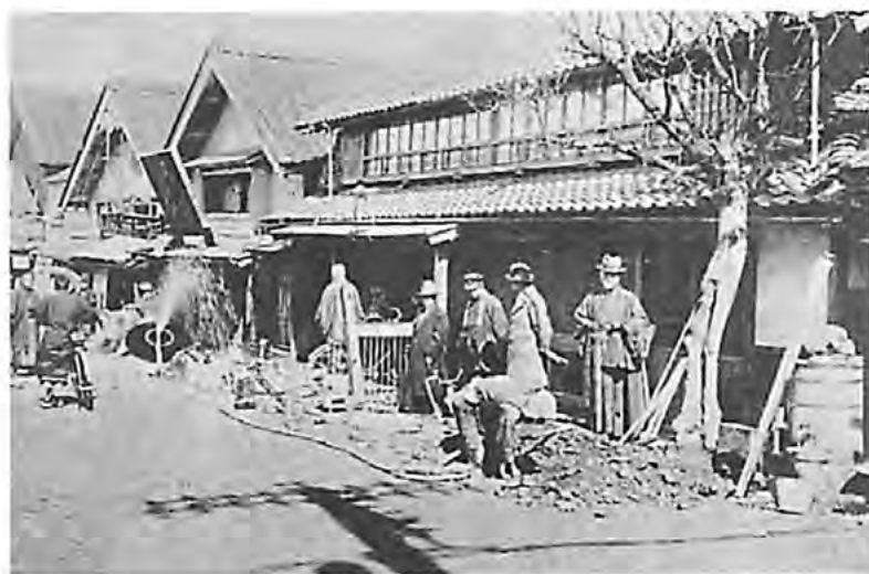
大正15年3月 給水設備の工事
