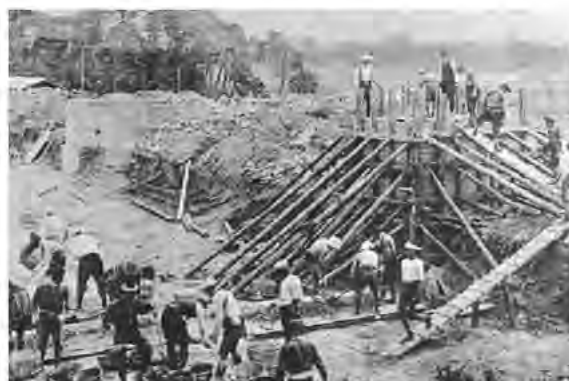
大正14年4月 坂田浄水場制水井の地下混凝土工事
