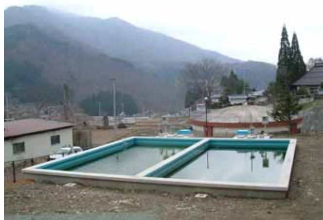
西原浄水場（平成 18 年しゅん工）
