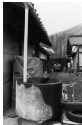
本郷町にある天水タンク 昔はこのように雨水を集水して日用水として使った。
