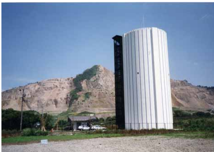
日滝原配水池（平成 9 年しゅん工）
