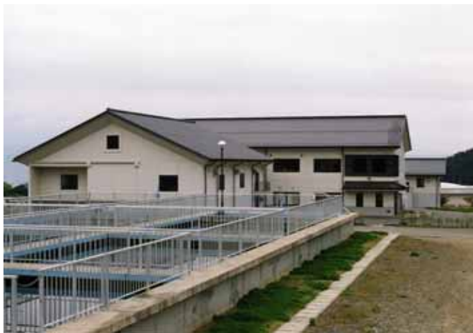
塩野浄水場（平成 8 年しゅん工）
