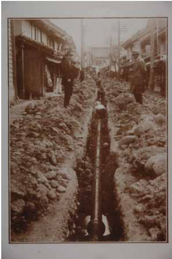
大正14年 4 月 中町通りで鉄管敷設工事
