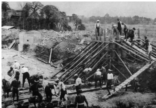
坂田浄水場制水井工事のようす
