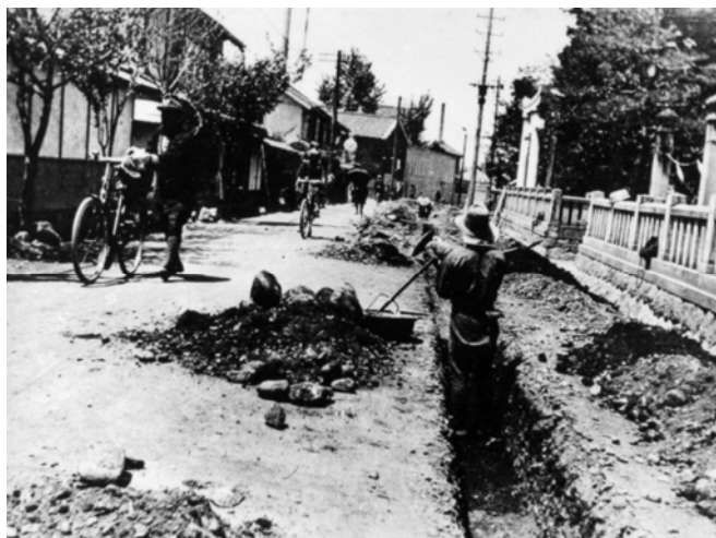
芝宮前の水道敷設工事のようす
