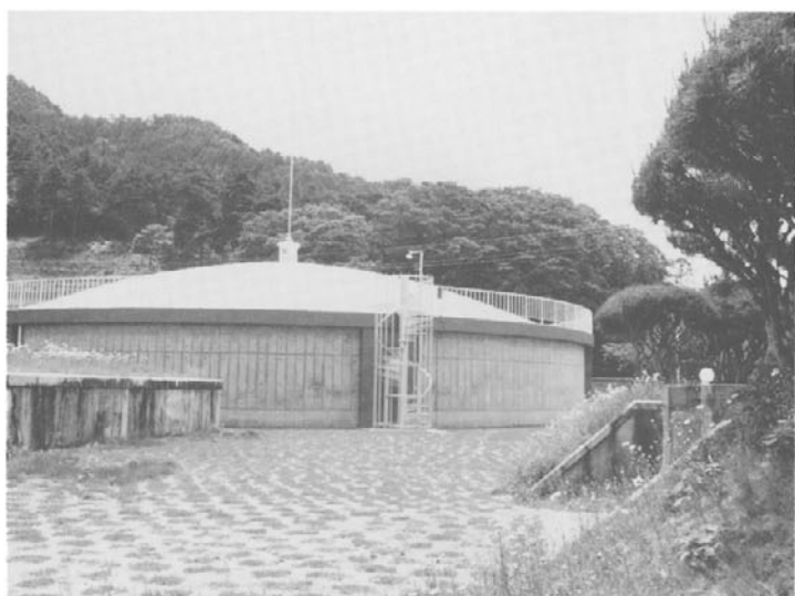
△昭和60年に完成した3,000m 3 タンク(坂田浄水場)
