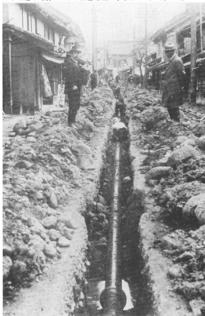
▽中町通り局前における鉄管布設工事(大正14年 4月15日)
