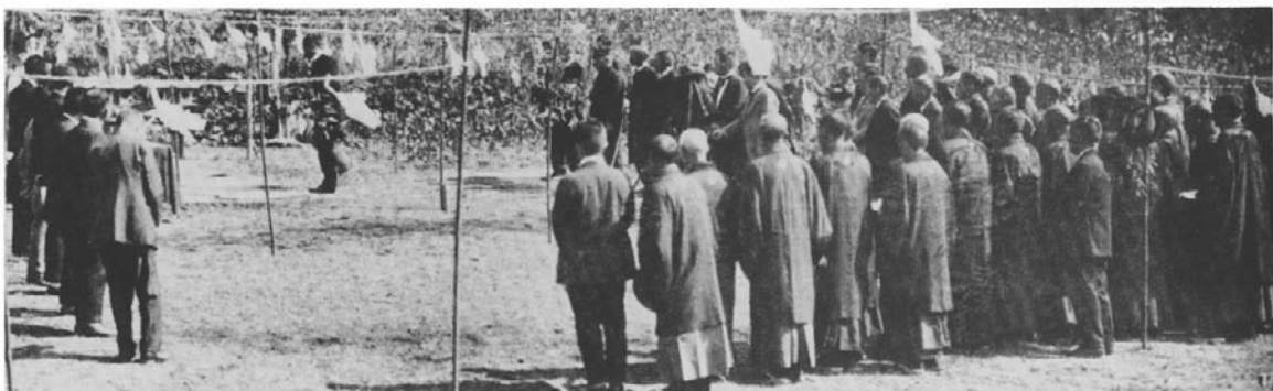
▷浄水場における地鎮祭 (大正13年10月15日)
