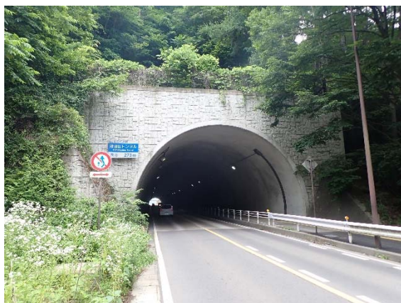
鎌田山トンネル坑門部
