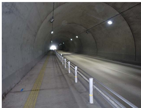
鎌田山トンネル覆工部
