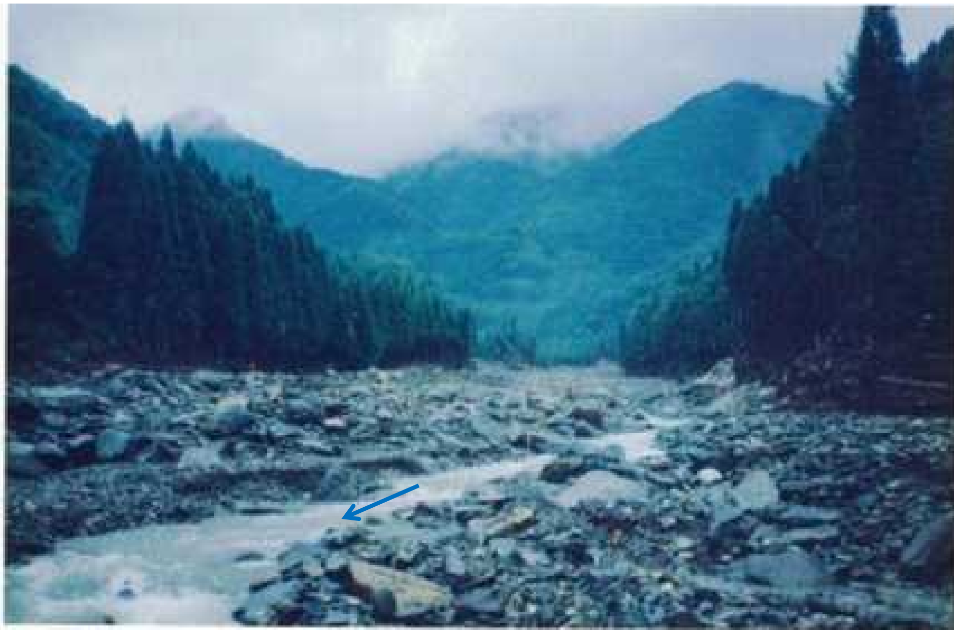
西原付近：着手前
