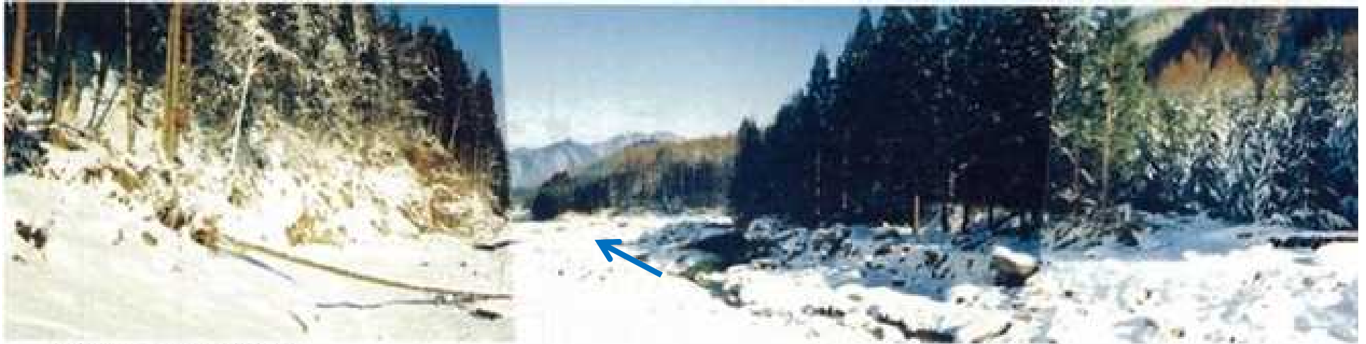
着手前 上流から下流を望む
