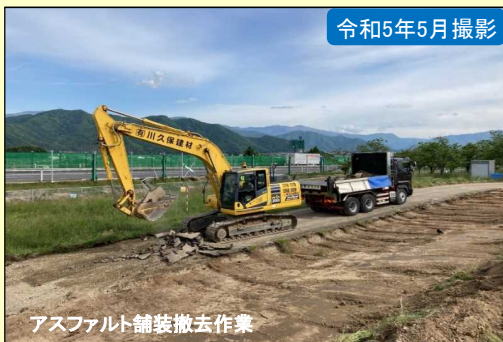
現地施工状況②
