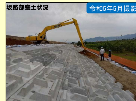
現地施工状況②
