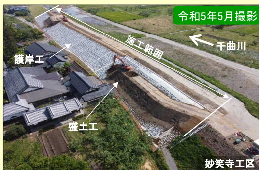
現地施工状況②
