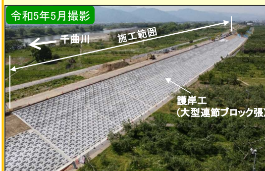
現地施工状況①
