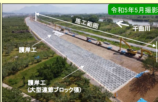
現地施工状況②
