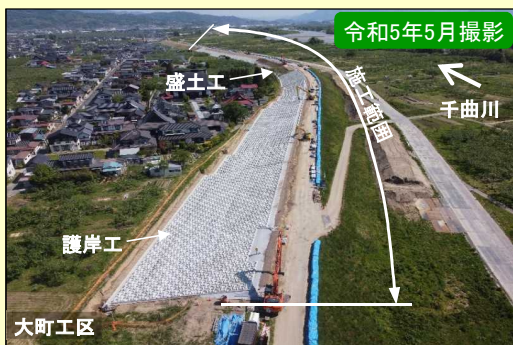
現地施工状況①
