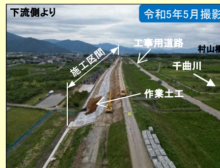
現地施工状況①
