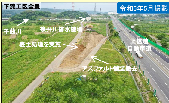
現地施工状況①
