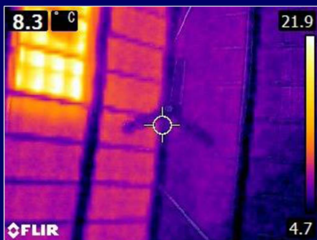
室内からの醤油蔵屋根面の熱画像 (2016.1.10)
