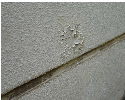
上町コミュニティ住宅 外壁
