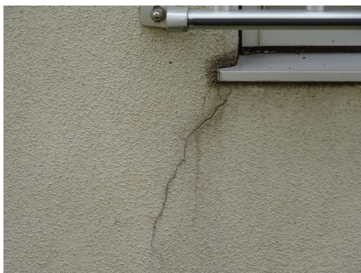
Y1号棟 外壁・開口部
