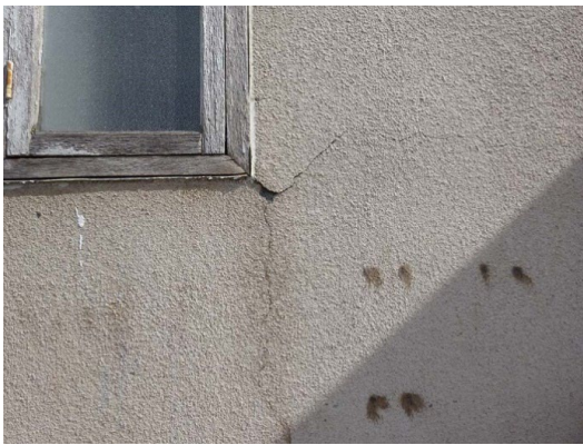
7～12号 外壁・開口部
