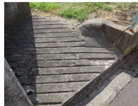
13～16号 外壁・外構
