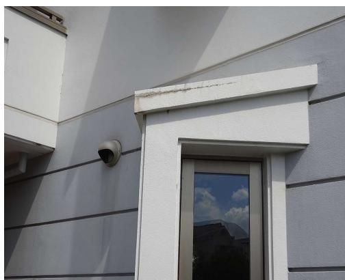
上町コミュニティ住宅 外壁
