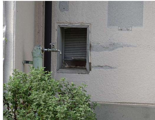
49～53号 外壁・開口部
