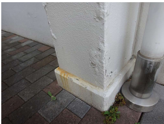
穀町コミュニティ住宅 外壁
