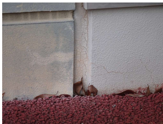
穀町コミュニティ住宅 基礎・外構
