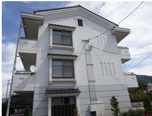
上町コミュニティ住宅 外観
