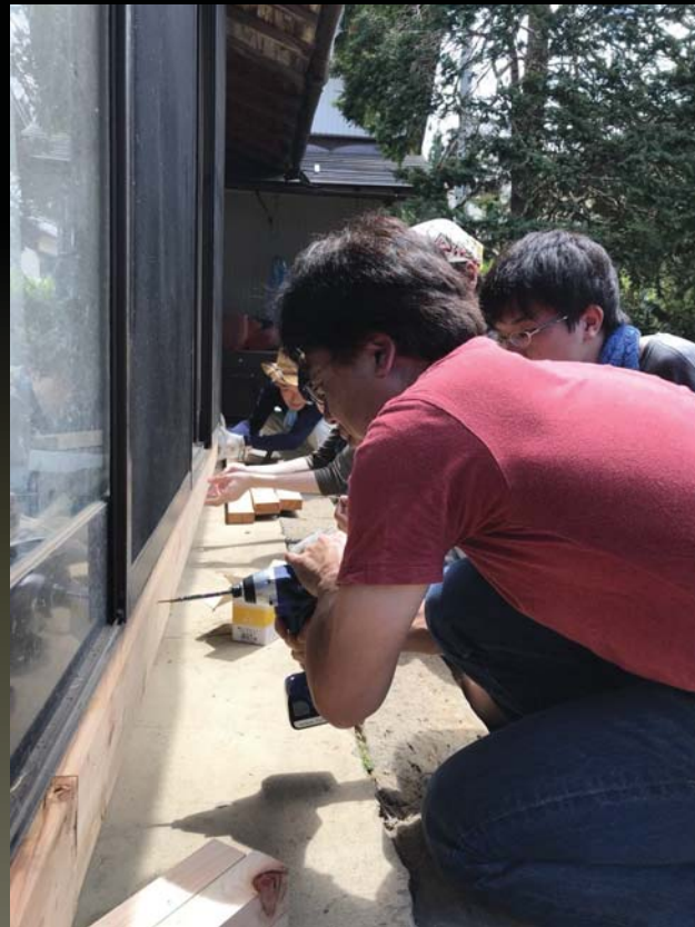
濡れ縁の 受材を取り付ける
