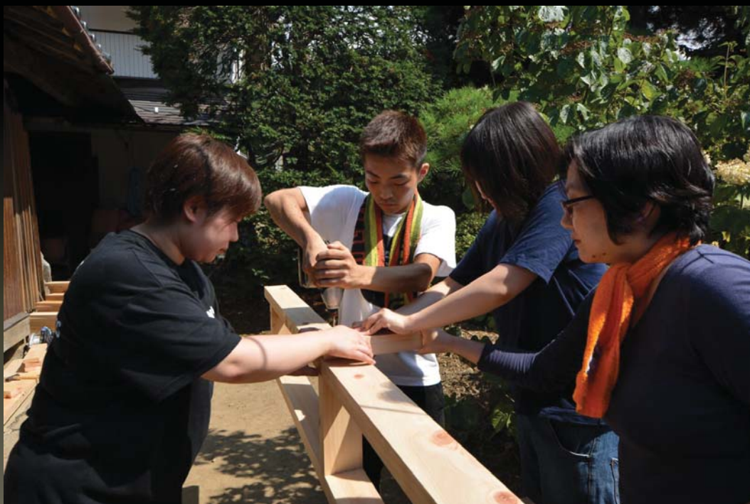
濡れ縁の土台部分を先に制作する
