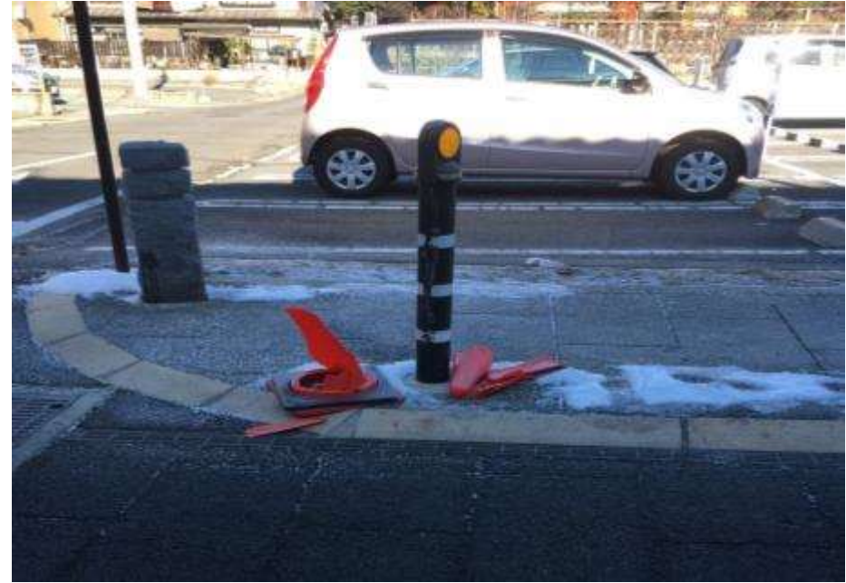
壊れたコーン (銀座通り)
