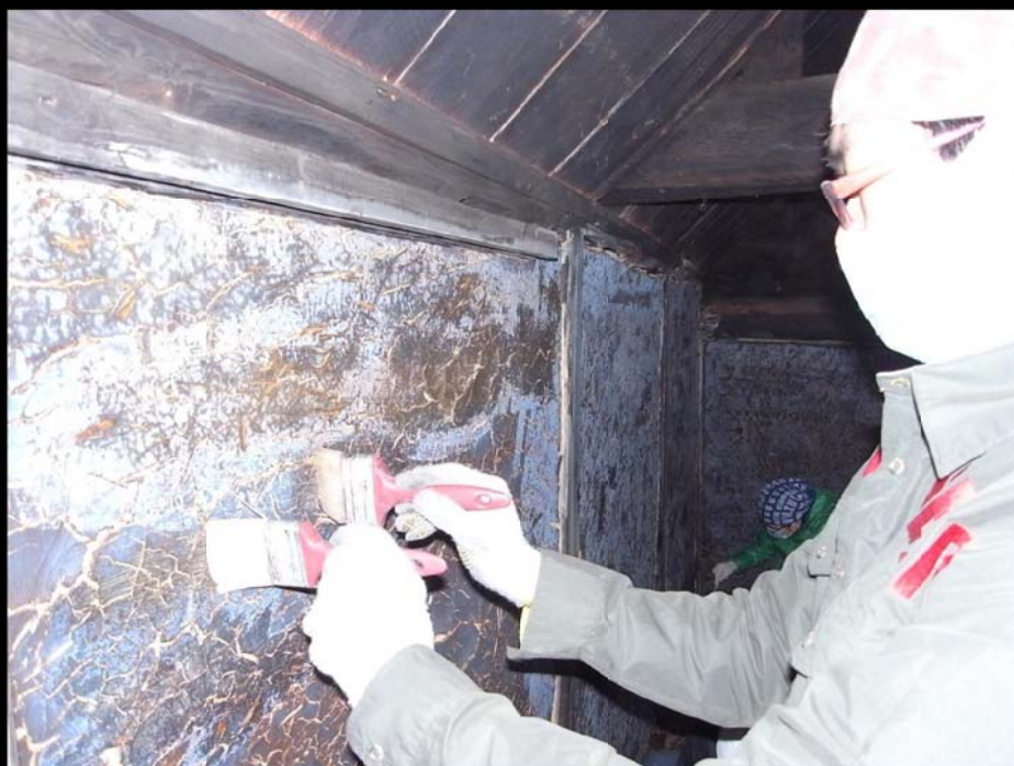
古民家2階の土壁塗り(2回目) 以前の下塗りの上に、接着剤を塗布しているところ
