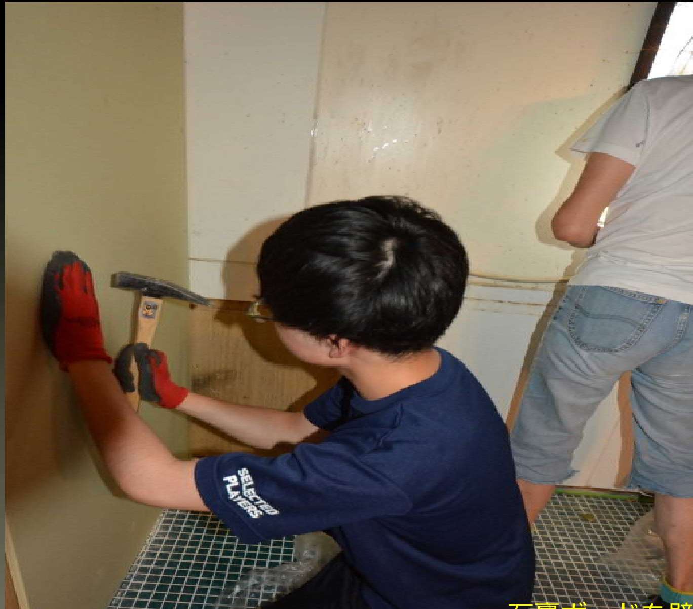
石膏ボードを壁に張り付ける
