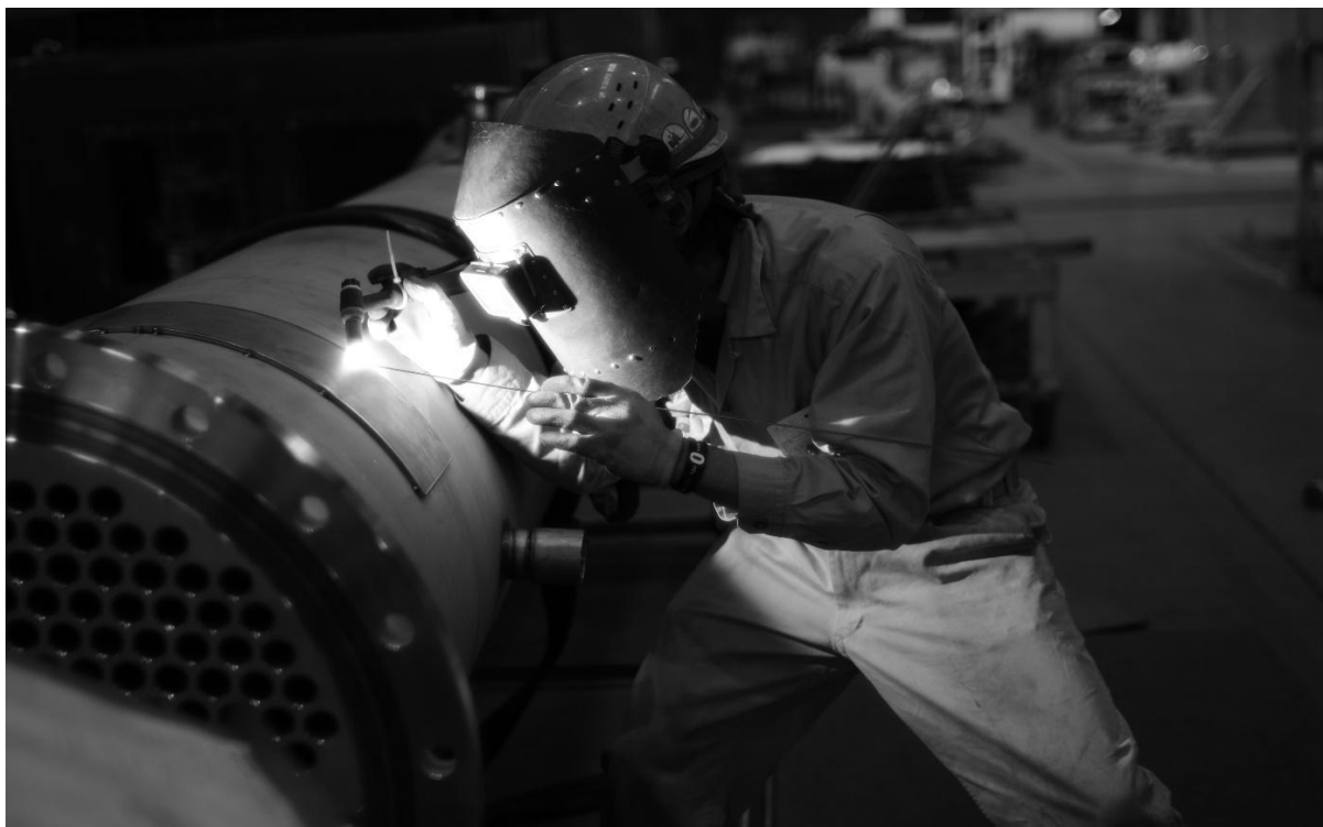
大型熱交換器の溶接作業
