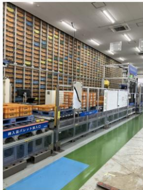
搬送・反転・検査が連動するライン構成
