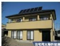
住宅用太陽熱給湯
