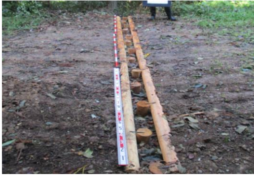
流出防止に効果を発揮した「路面水切工」
