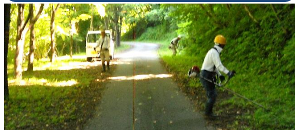
【昇竜湖宝探しウォーク」のダム湖周道路を除草整備】
