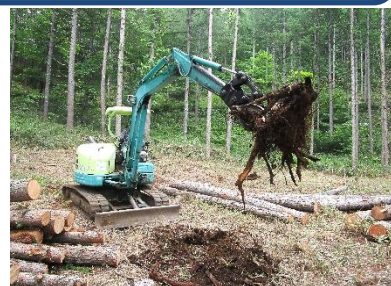
【重機により「切り株」を伐根】
