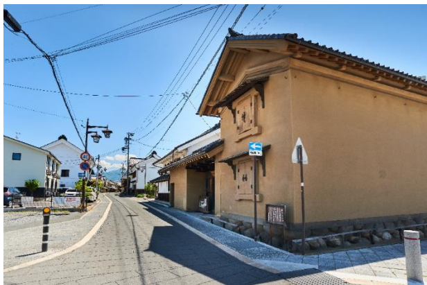
土蔵造りの町並みの玄関口 ぼたもち石積みの土蔵 (東横町)
