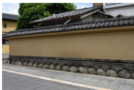
塀の基礎に設けられたぼたもち石積み
