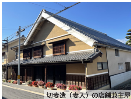
切妻造（妻入）の店舗兼主屋
