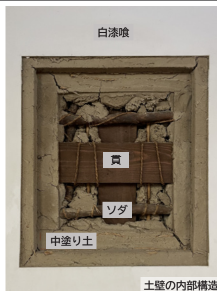
土壁の内部構造
