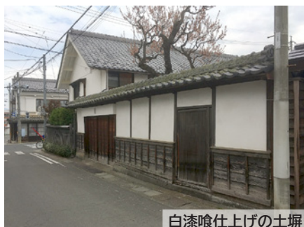
白漆喰仕上げの土塀
