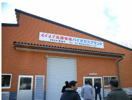
プラント建屋
