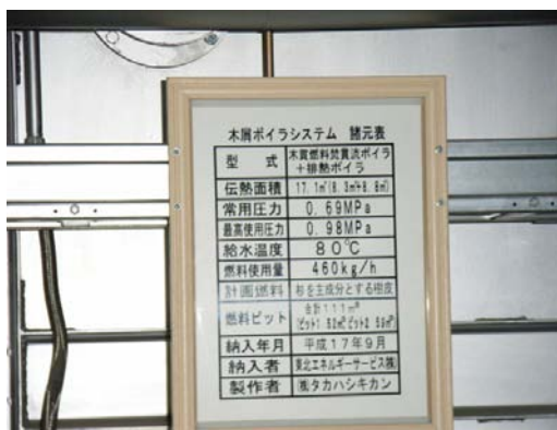
木質ボイラ銘板
