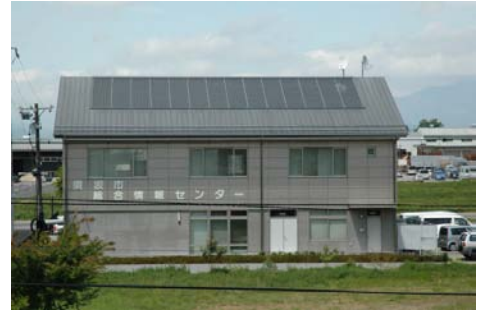
図 5-3 総合情報センターの10kWクラスの太陽光発電設置例（大字井上）
