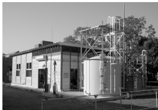
図 3-37 生ゴミ系的高速メタン発酵の実験施設
