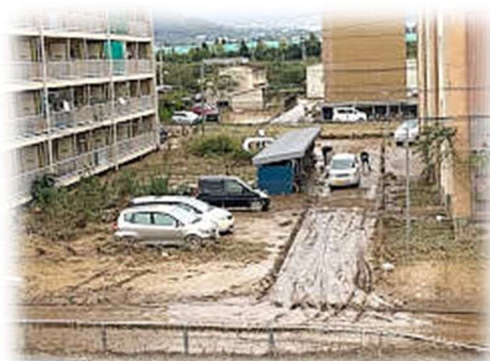
令和元年東日本台風の被害
