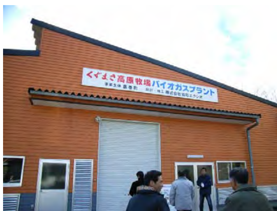
プラント建屋
