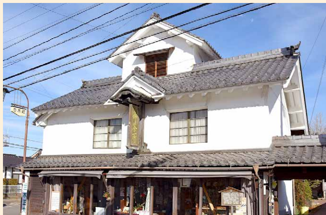
建物の2階にのる望楼(宇治の園茶舗)
