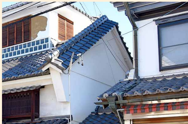
隣家との境に設けられた卯建(山下薬局)
