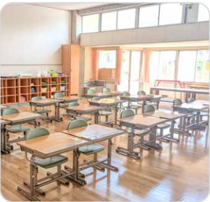
須坂小学校・須坂支援学校の改修工事
