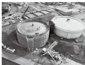
塩野浄水場の浄水池建設工事の様子
