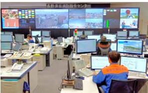
長野須坂消防指令センター
