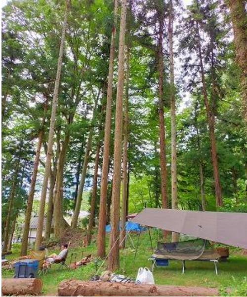
【山の神キャンプ場整備の様子と完成した写真】
