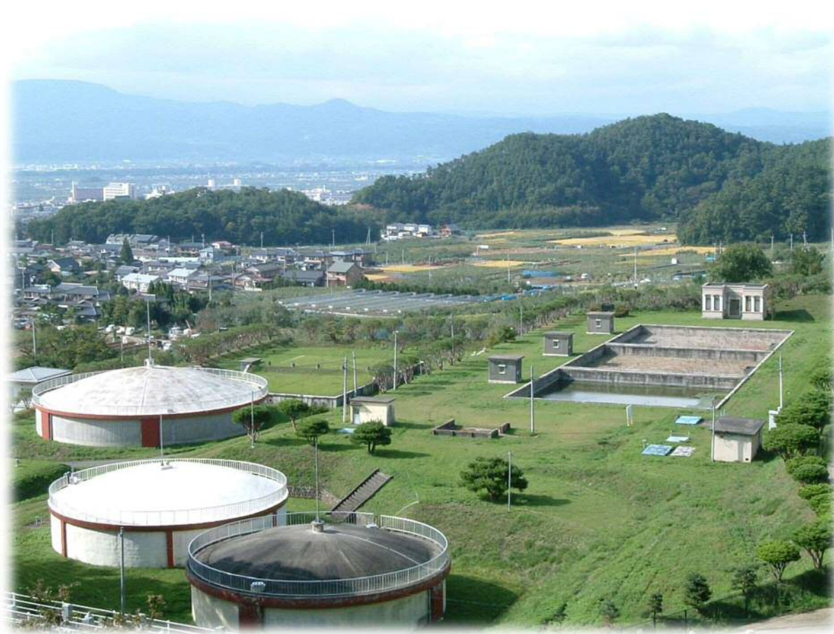
坂田浄水場全景
